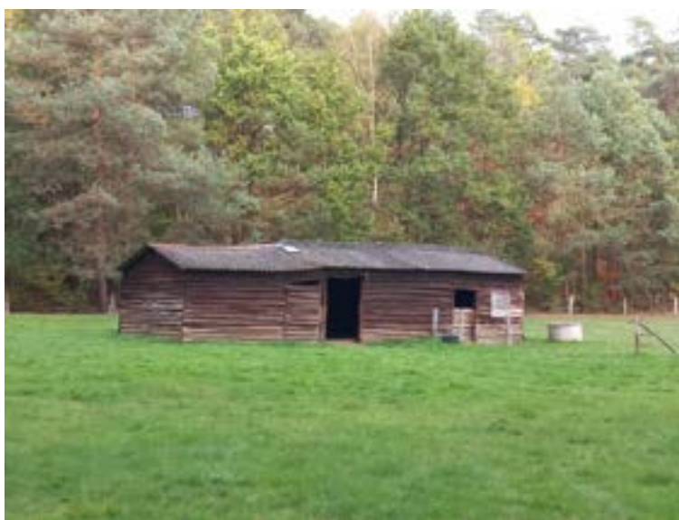
Figuur 12: Asbestdak
