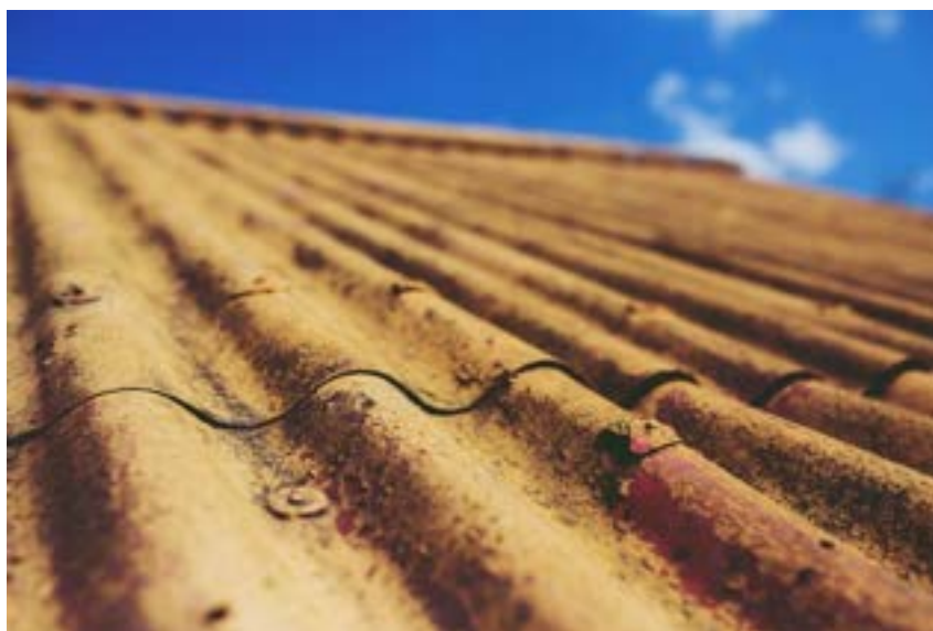
Figuur 26: Campagnebeeld kaart asbestverdachte daken
